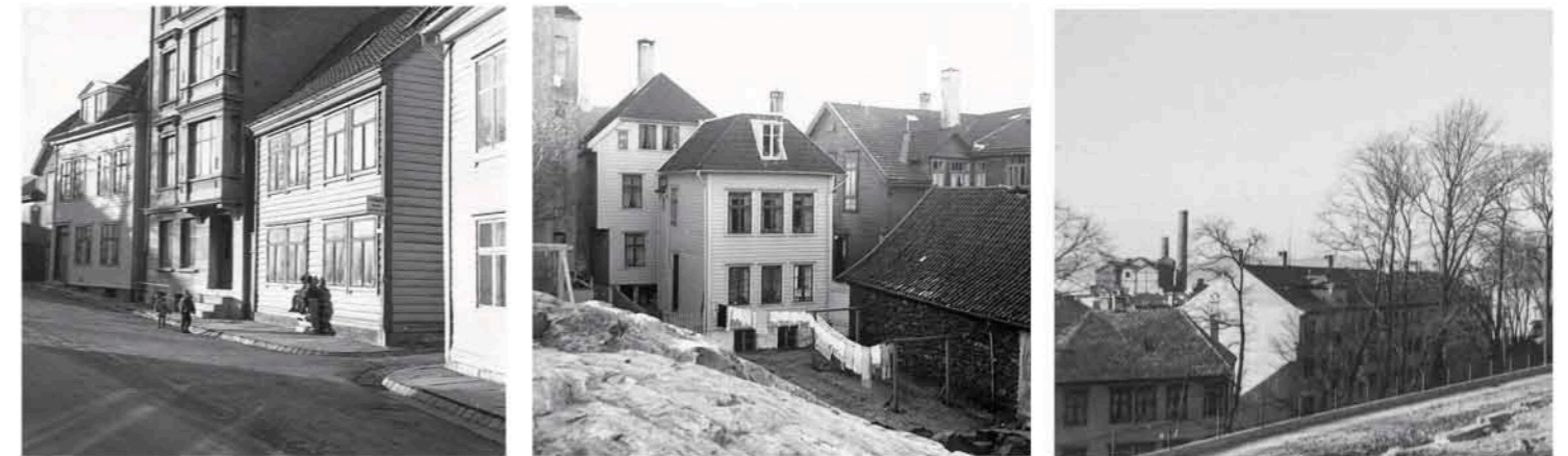
Dokkeveien 1951 - Fasadar på nordsida
